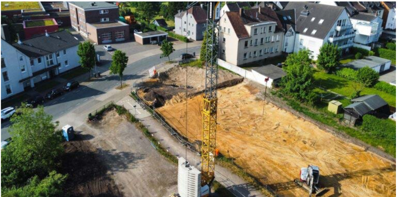
Baustelle von oben: An der Feldstraße 40 entstehen Appartements für alte, pflegebedürftige und schwerkranke Menschen. © Michael Sawala
